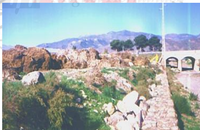
Figura I-6: Restos agrícolas acopiados cerca del cauce de un arroyo.
