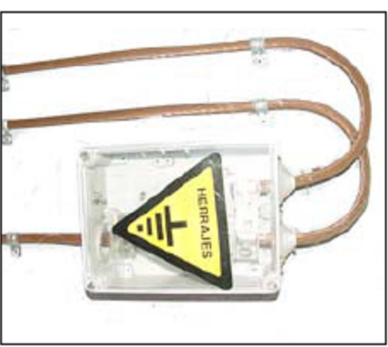
Caja de Seccionamiento de Protección
