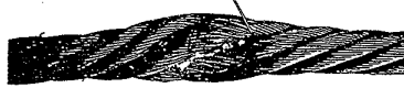
Cliché 18 - Aplastamiento por acción mecánica que da lugar a un laminado del cable. El cable debe ser retirado.
