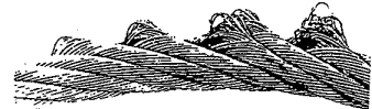
Cliché 12 - Agravación del defecto anterior en un grado que justifica la retirada inmediata del cable.
