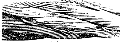
Cliché 1 - Roturas y arranques de alambres en dos cordones consecutivos (trenzado cruzado). El cable debe ser retirado.
