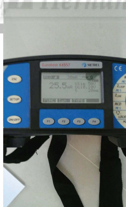
Fotografía 14. Detalle de la medición de la corriente de disparo de uno de los diferenciales instalados.
