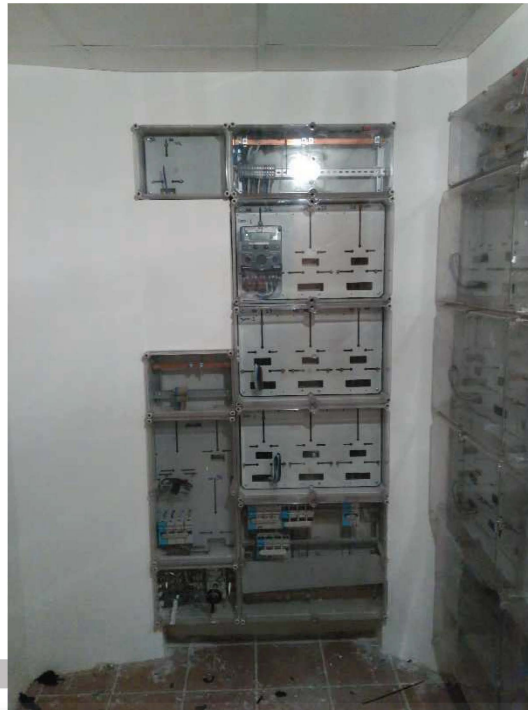
Fotografía 3. Detalle de la centralización de contadores. Modulo en el que se encuentra el contador de local.
