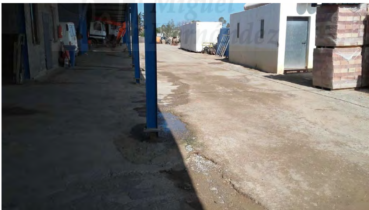
ESTRUCTURA DEL HANGAR
