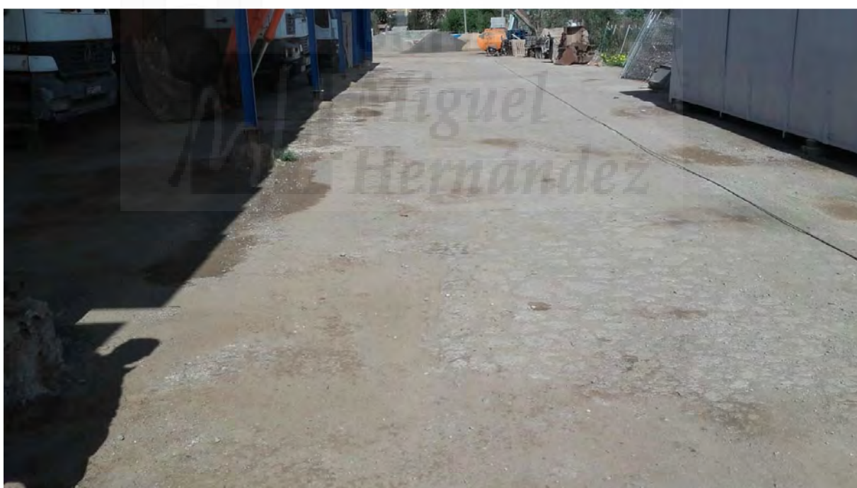
PAVIMENTO DE HORMIGON
