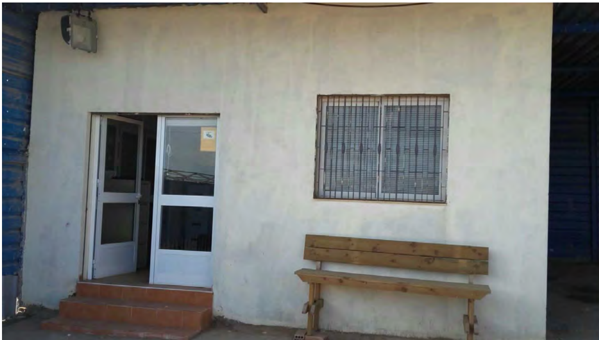
EDIFICIO DE OFICINAS
