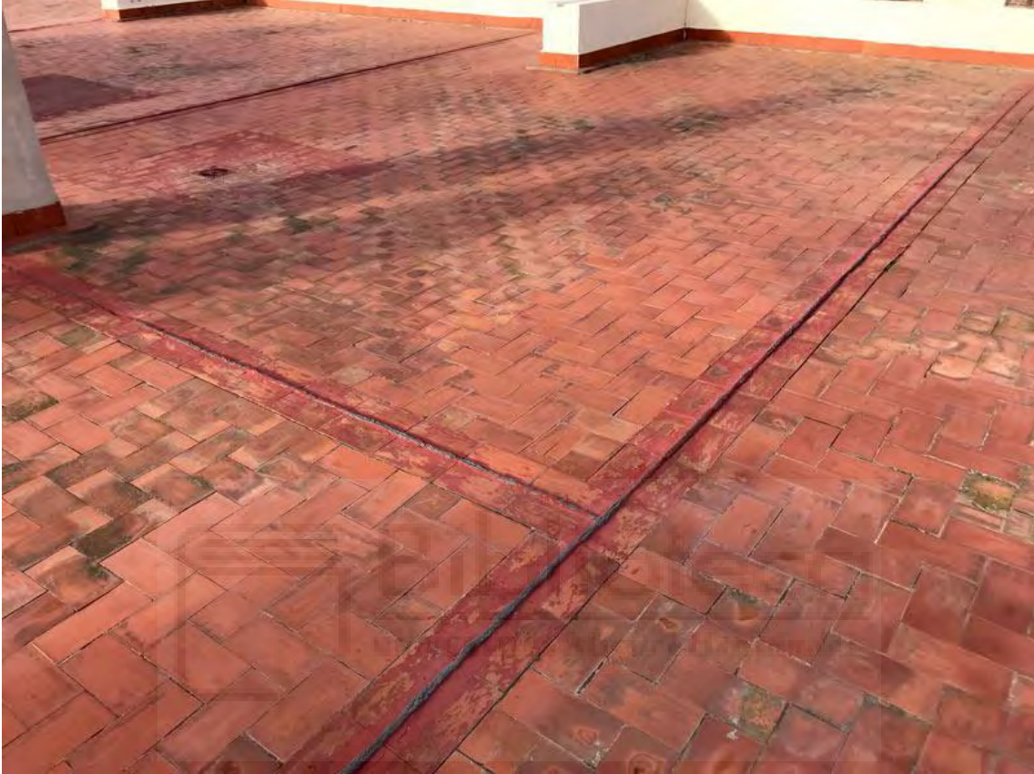
Ilustración 2. Cubierta del edificio del local comercial
