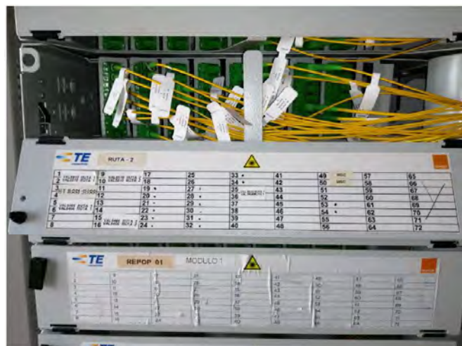
Figura 6: Repartidor del nodo situado en Avda. Costablanca
