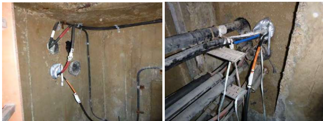
Figura 49: Interior CR12 tras la instalación. Conductos entrada y salida
