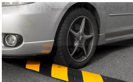
Figura 1.12. Impacto entre neumático y cara lateral de un resalto
