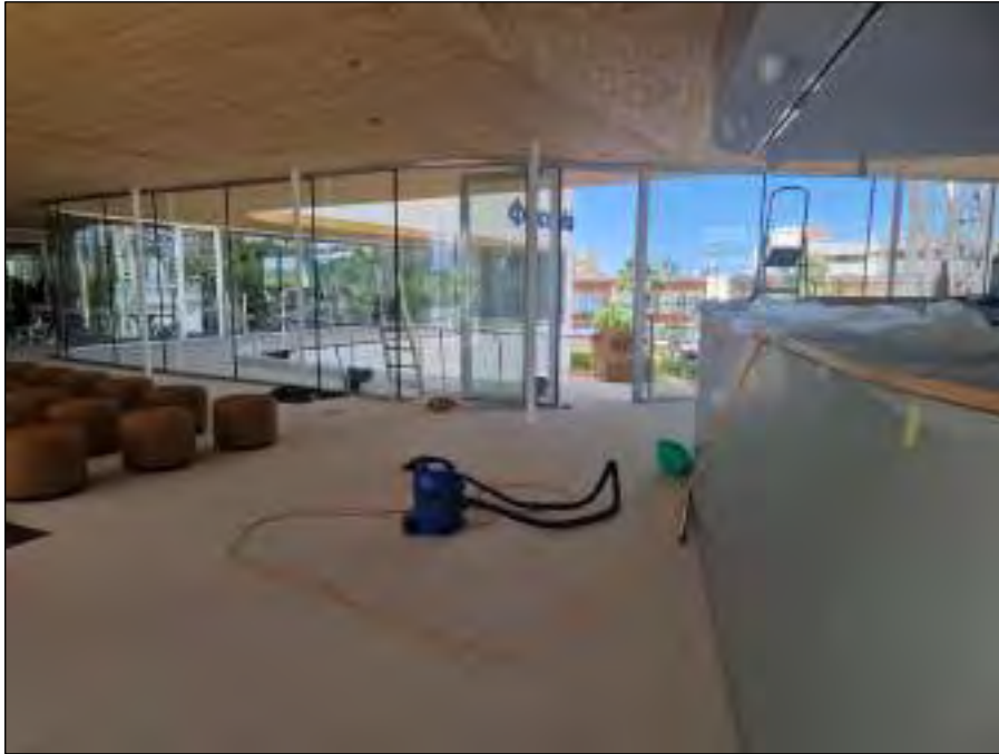
Figura 45.-Recepción de las oficinas.
