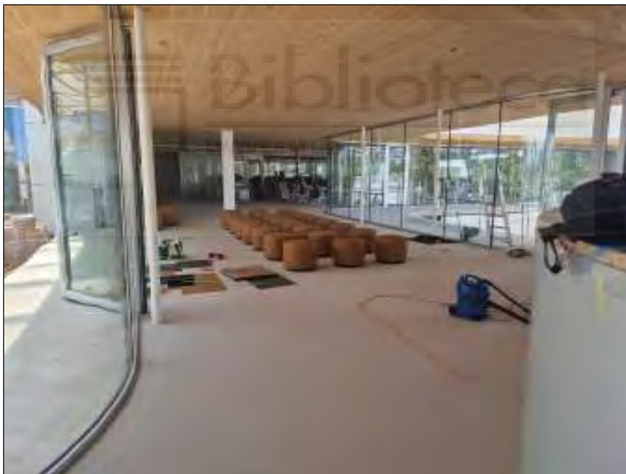
Figura 46.- Recepción y zona de conferencias.
