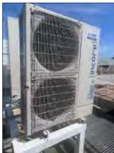
Figura 35.- Unidad exterior VRV PUMY-P112YKM.
