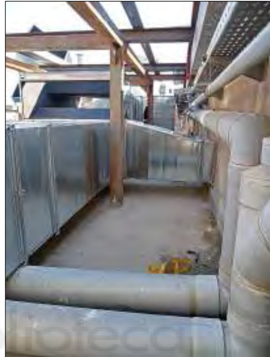
Figura 60.- Conducto de retorno Rooftop mediante chapa aislada. Figura 61.- Conducto de impulsión Rooftop mediante chapa aislada.
