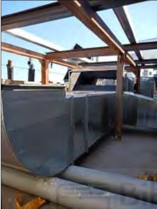
Figura 60.- Conducto de retorno Rooftop mediante chapa aislada. Figura 61.- Conducto de impulsión Rooftop mediante chapa aislada.
