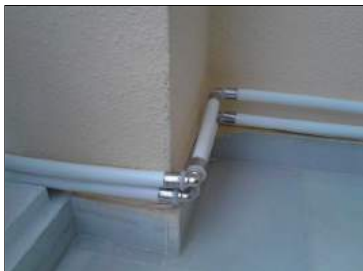
Figura 78. Tubería multicapa.
