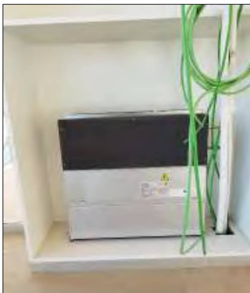
Figura 37.- Unidad interior PFFY en mueble (sin colgar). Figura 38.- Resultado de cómo queda la unidad interior en el mueble.
