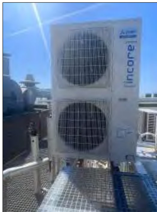
Figura 40.- Unidad exterior VRV PUMY P-300YKM.
