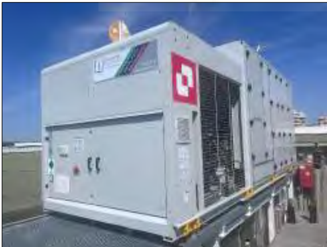
Figura 62.- Rooftop de Climaveneta modelo WSM2 0264.
