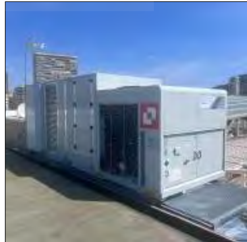
Figura 63.- Rooftop de Climaveneta modelo WSM2.
