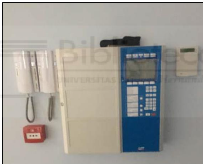
Figura 2. Central de detección de incendios analógica LST BC600.
