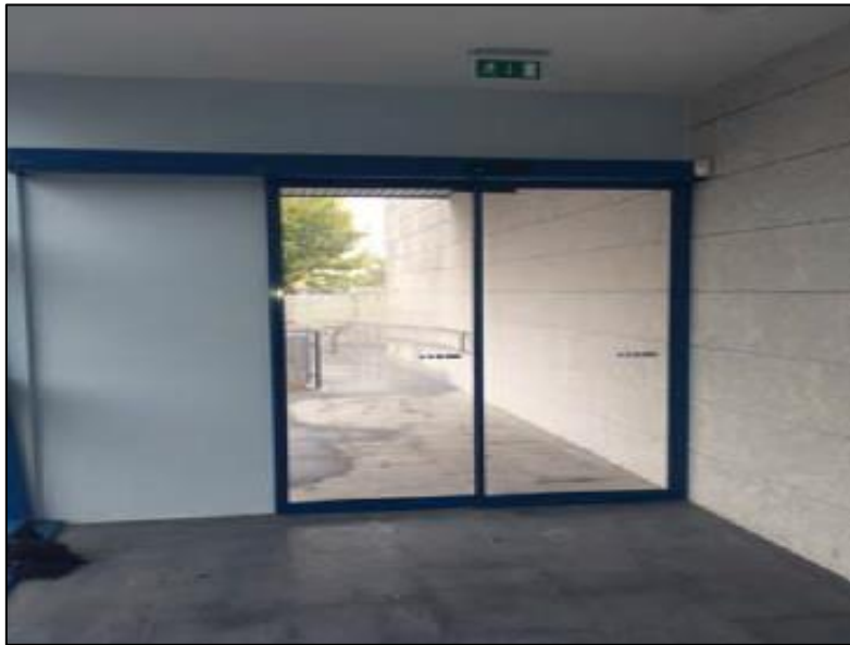
Figura 5. Alumbrado de emergencia en salida principal.
