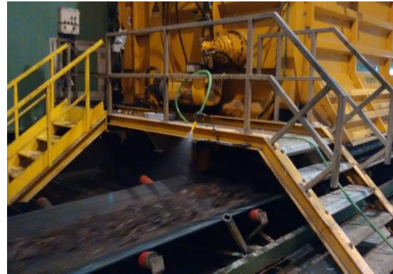
Figura 3.12. Riego de la pila túnel.
