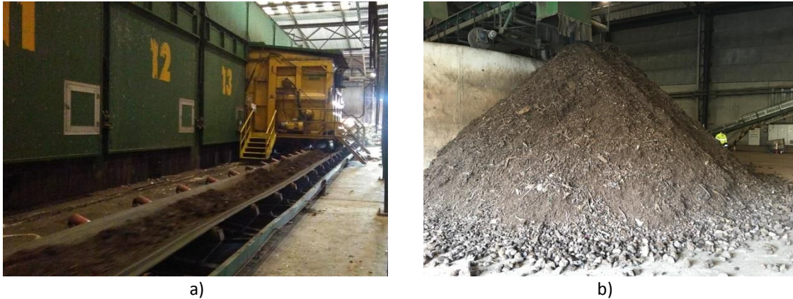
Figura 3.7. Secuencia de la operativa de descarga de la pila túnel: a) máquina descargadora y cinta transportadora; y b) tolva de salida.
