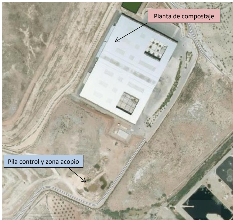
Figura 3.2. Ubicación de los túneles de compostaje, de la zona exterior de acopio y de la zona de estancia de la pila exterior control.
