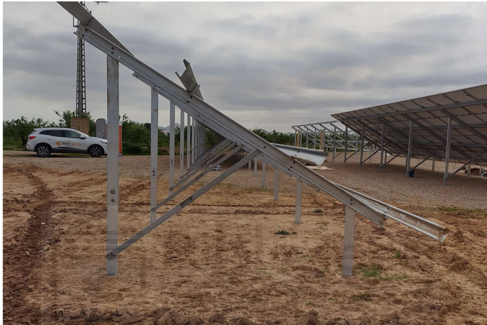
Estructura fija de acero, hincada.
