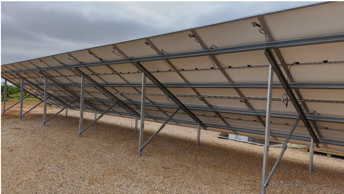
Hincado de estructura, sin cimentación.
