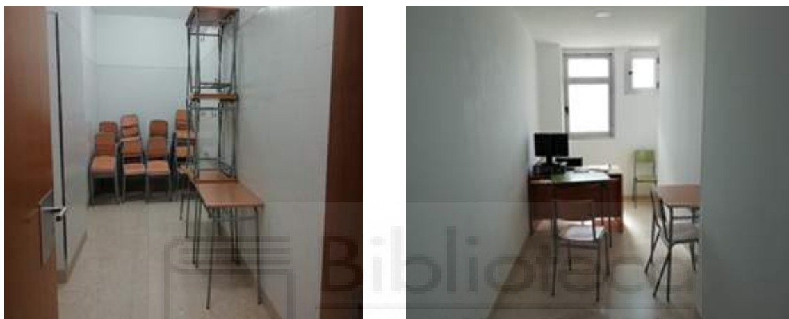
a) Espacio “zulo”, sin luz ni ventilación natural, usado como almacén.
