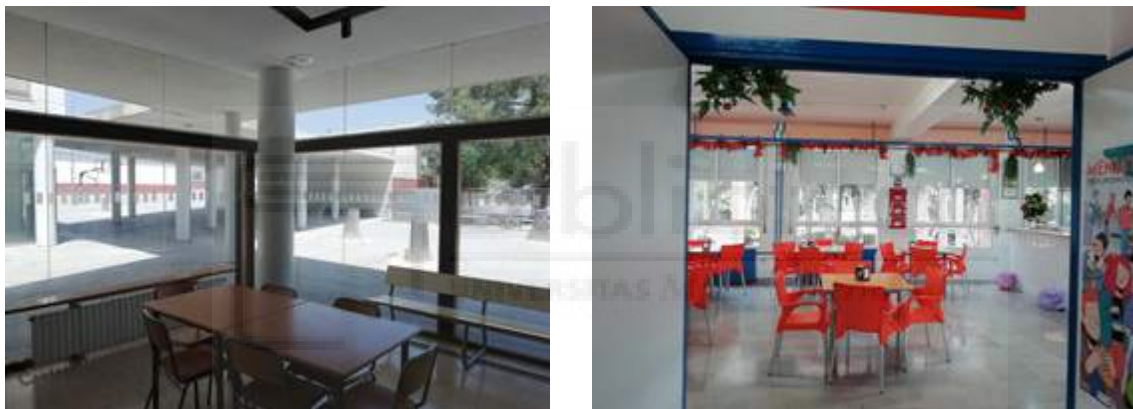
a) Espacio “pecera”. Cafetería sin ventilación natural en un edificio moderno.
