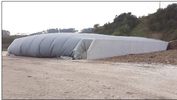
Figura 3.13. Efecto de hinchado de la lona durante la ventilación
