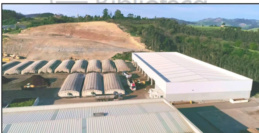
Figura 3.1.: Trincheras ventiladas con cubierta semipermeable, nave de maduración, labores de mezclado y de carga de compost.
