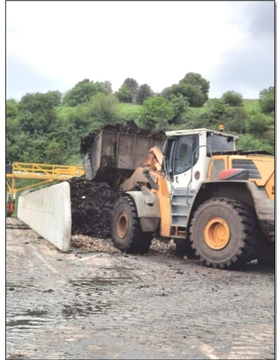
Figura 3.4. Carga de mezcla a trinchera con pala cargadora
