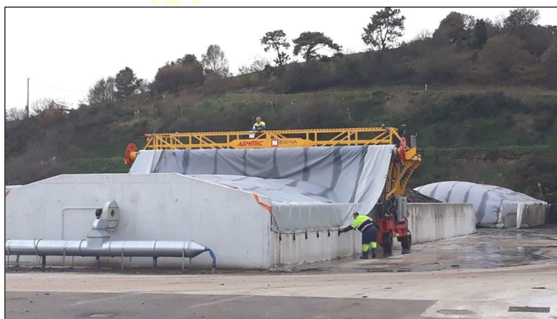
Figura 3.5. Trabajos de colocación de lona con equipo autopropulsado
