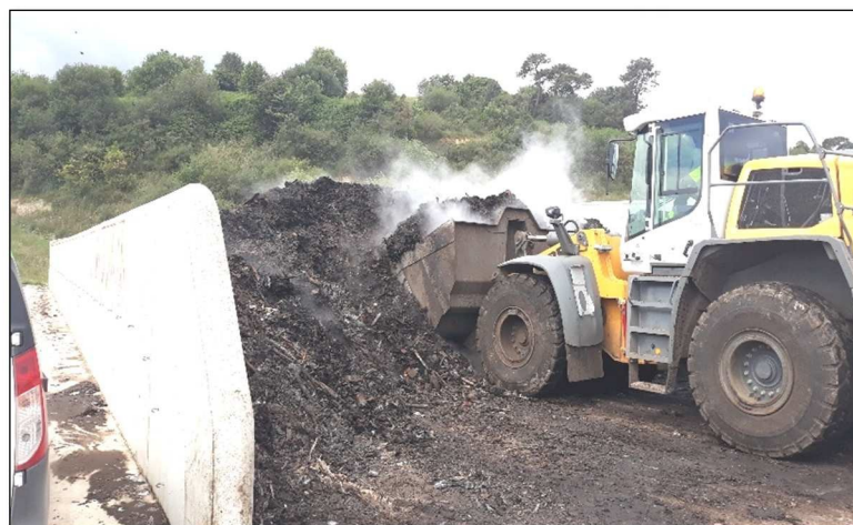
Figura 3.6. Inicio del vaciado de una trinchera
