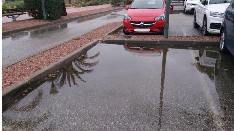
Figura 7. Acumulación de flujo en la zona de aparcamiento del sector norte tras una precipitación acumulada de 17,2 mm en 72 h (8 de enero de 2021) [78].
