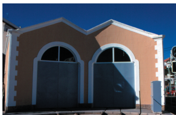
Fachada frontal del hangar.
