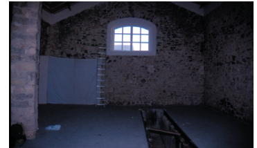
Interior del hangar.
